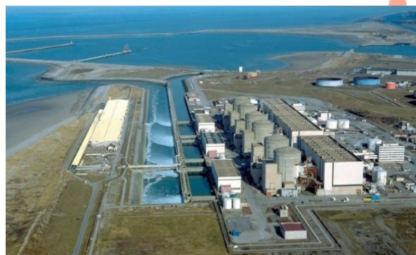
Visite et Communication Centrale Nucléaire de Gravelines
